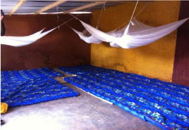
Foto 19. Aspecto final del interior del dormitorio.
