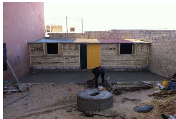
Foto 12. Trabajos de finicion del patio del dormitorio.
