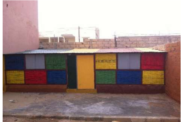
Foto 20. Aspecto final del exterior del dormitorio.
