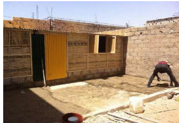
Foto 10. Trabajos de preparación del patio del dormitorio .
