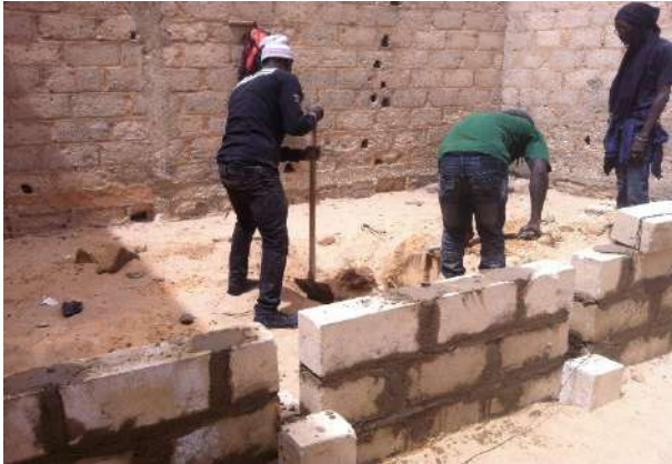
Foto 7. Miembros del equipo construyendo el suelo del dormitorio.
