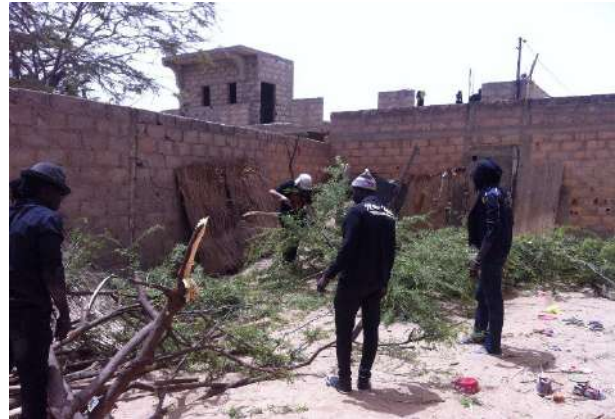
Foto2. El equipo realizando los primeros trabajos de preparacion del terreno.
