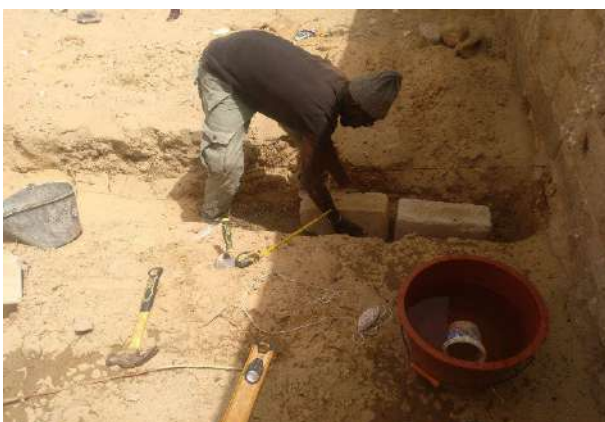
Foto 5 . Un miembro de Keur Talibe Ndar haciendola zanja para los cimientos.
